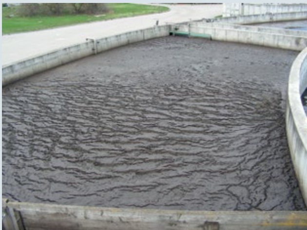
Pilt 5. Munitsipaalheitveekäitlusjaam enne ja pärast GREASOLUXi kasutamist mõne kuu vältel – aeratsioonimahutit katnud rasvakiht on vähenenud drastiliselt
